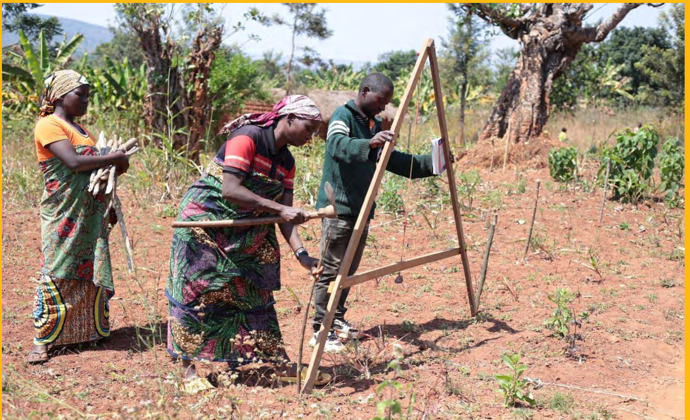
Photo : Mesurage de la première courbe de niveau, colline Gisoro, sous-colline Mungwa
